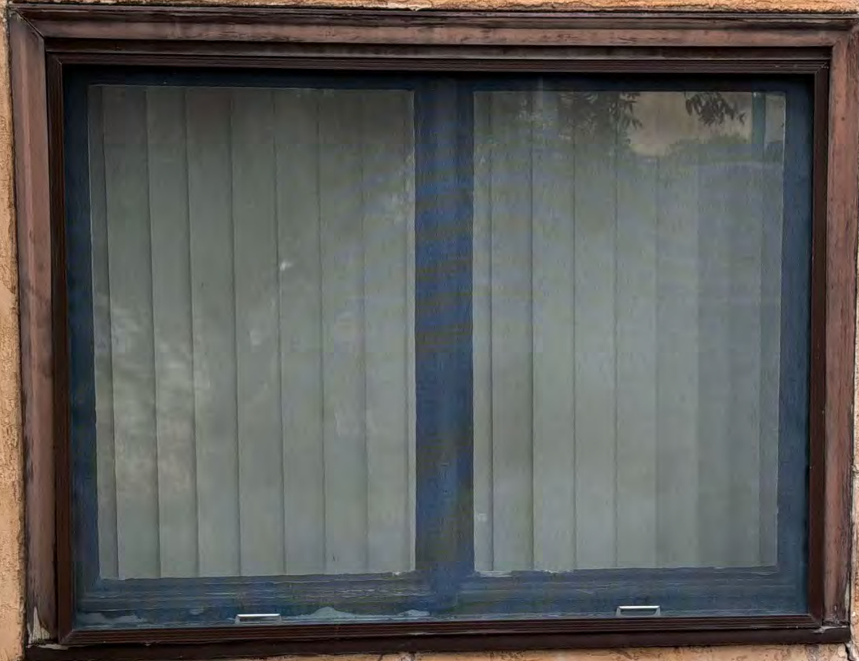
East Elevation Window F.
