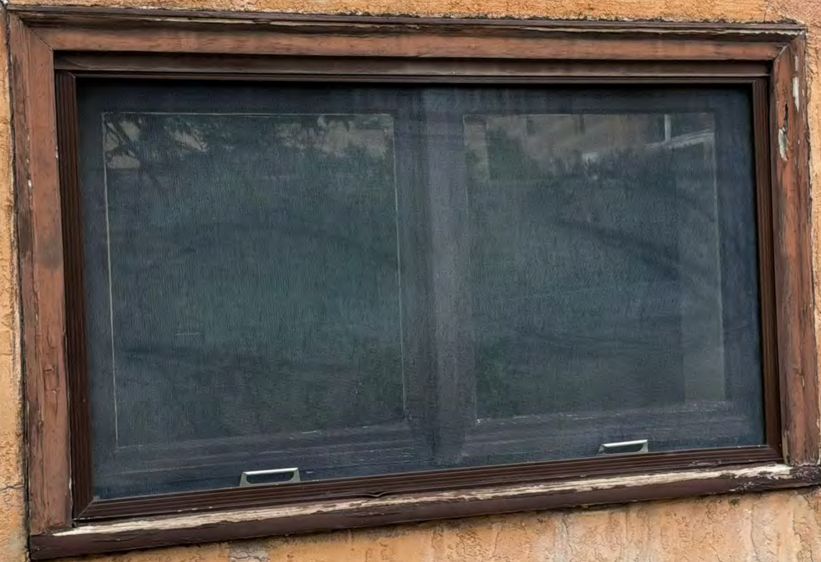
East Elevation Window G.
